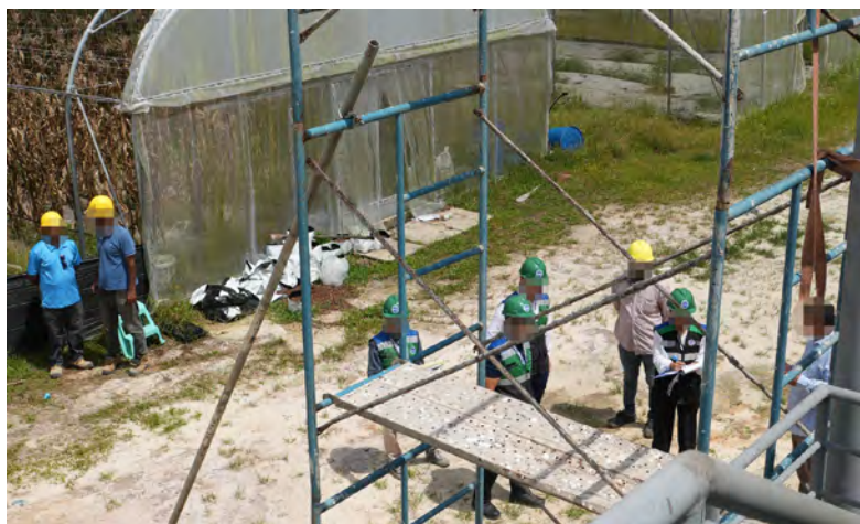
PEMERIKSAAN yang dijalankan di sebuah tapak kerja pembinaan yang terletak di Lebuhraya Tungku, Bandar Seri Begawan.
