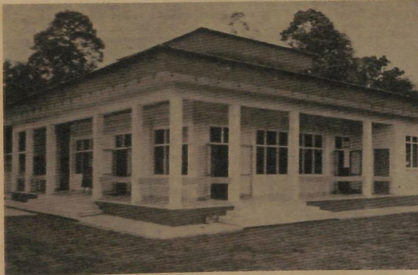
BANGUNAN Masjid Kampung Panchor Murai yang baru dibuka rasmi.
