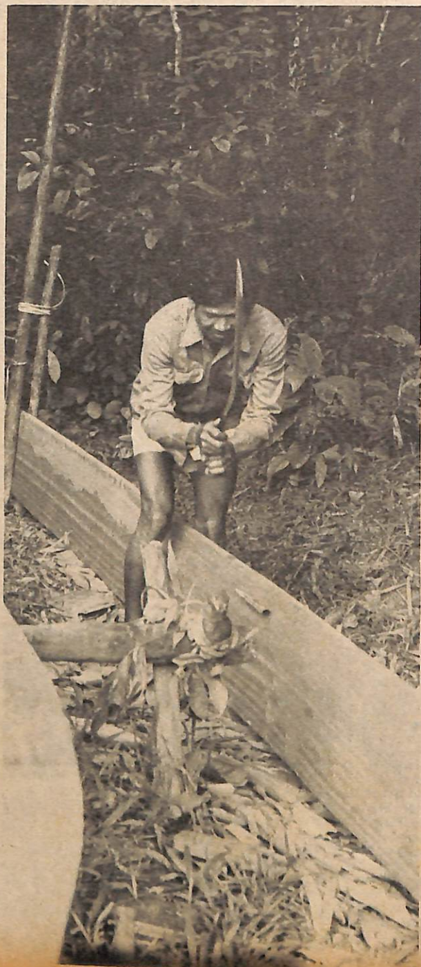
Salah satu warisan tradisi yang masih diamalkan oleh penduduk- penduduk di Kg. Belabau ialah 'memburis perahu'. Awg. Umar bin Sat sedang menarah kepingan papan untuk dibuat perahu (bawah).
