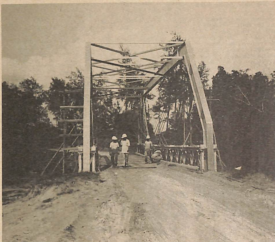
KELIHATAN kerja-kerja pembaikan sedang dijalankan oleh pekerja-pekerja di salah sebuah jambatan.
