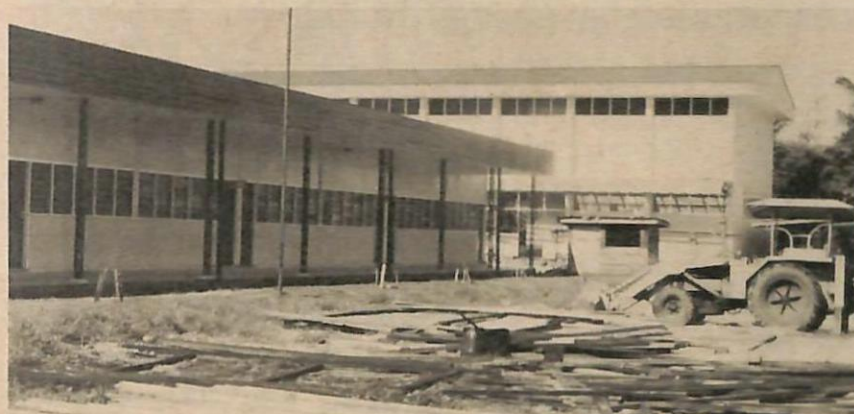
BANGUNAN Sekolah Melayu Pengiran Muda Mahkota di-Kampung Kuala Tutong yang hampir siap pembenaan-nya.
