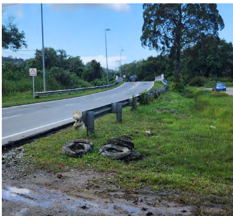
SYARIKAT tersebut telah melakukan kesalahan berkenaan berdekatan dengan jambatan di bahu jalan Kampung Keriam Tutong.
