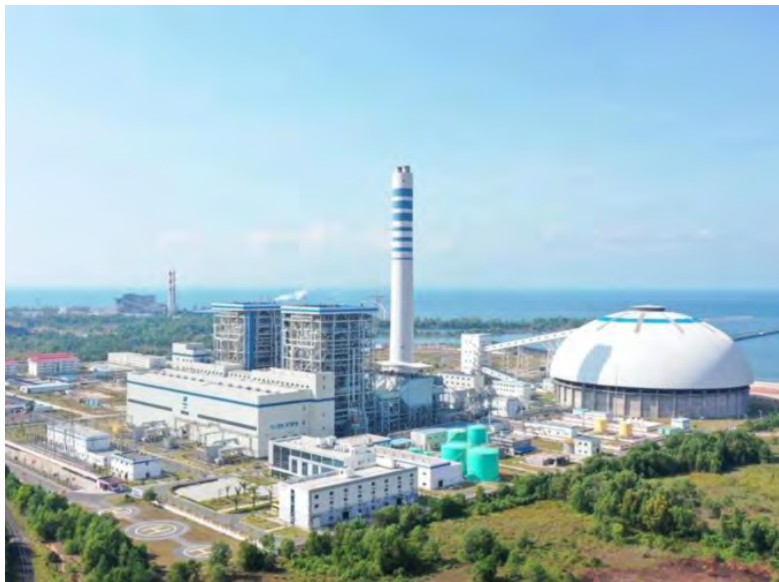
HUADIAN Sihanoukville Power Generation Co., Ltd. di Sihanoukville, barat daya Kemboja.
