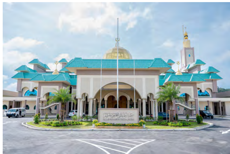
MASJID An-Na'im, Kampung Panchor Mengkubau.
