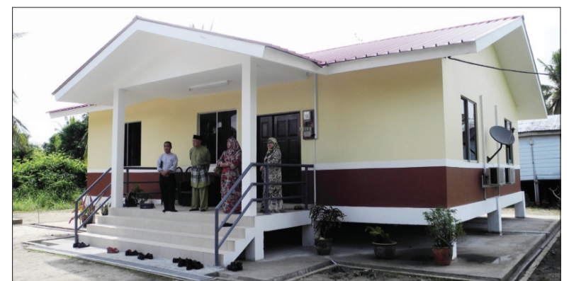
RUMAH baharu Dayang Samanah yang lebih selesa dan selamat.
