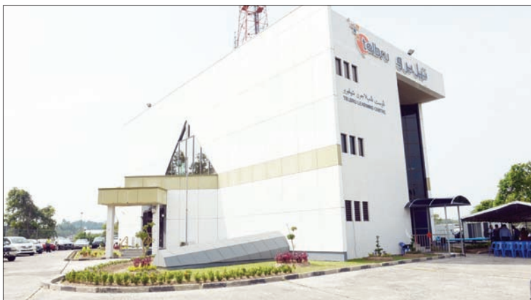
PUSAT Pembelajaran TelBru yang terletak di Bangunan TelBru, Jalan Pasir Berakas ini diharap dapat menggalakkan pembinaan keupayaan serta membangunkan organisasi ke arah kecemerlangan perkhidmatan dan mewujudkan kecekapan operasi.
