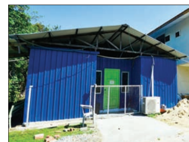
PEJABAT Lambak Standby Base, Jabatan Perkhidmatan Elektrik.
