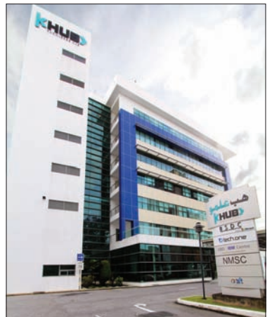
BANGUNAN Hub Ilmu (KHUB).
