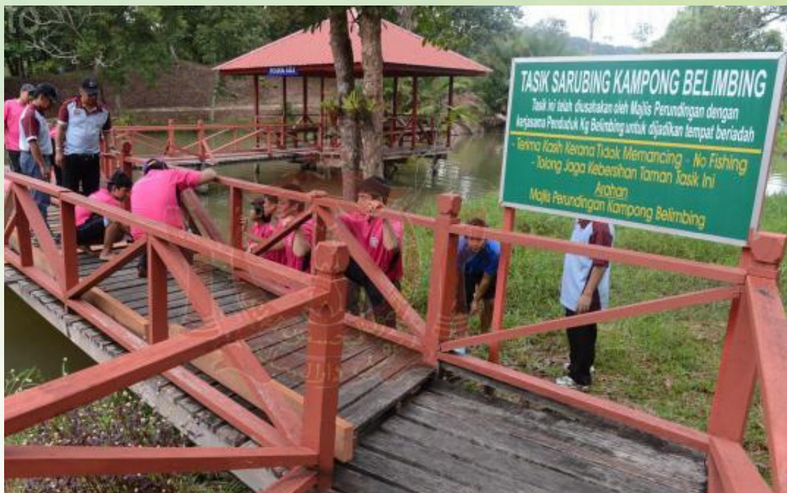
BELIA membantu kerja-kerja membaiki pulih jambatan yang terdapat di Tasik Sarubing.
