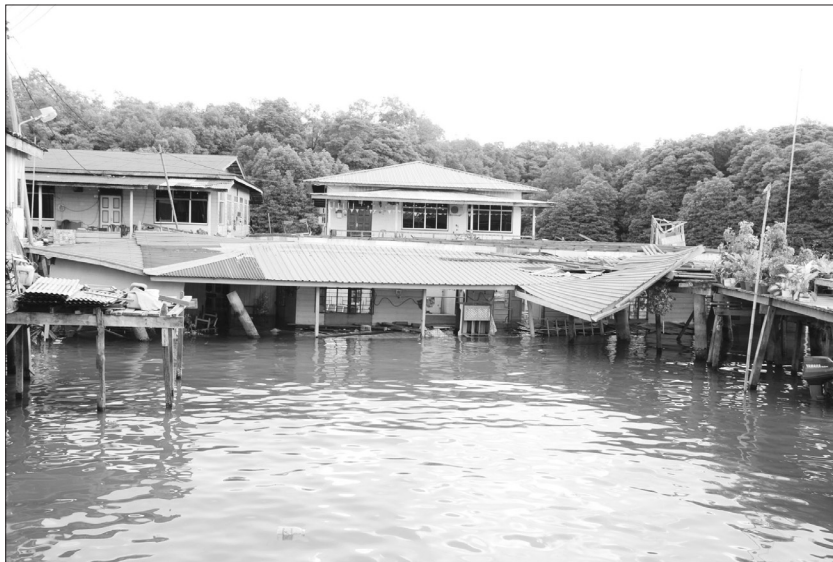
RUMAH Dayang Hajah Maisalamah yang telah runtuh ditenggelami air.
