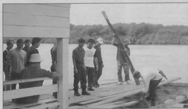
BERAT SAMA DIPIKUL RINGAN SAMA DIJINJING... Kerja-kerja membaiki jeti Jalan Kampong Melayu Asli dilaksanakan secara bergotong-goyong.
