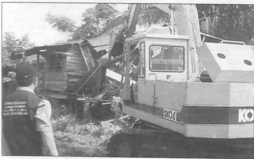
JENTERA berat digunakan bagi operasi meroboh rumah setinggan di Kampong Jabang yang terbiar kosong tidak berpenghuni.
