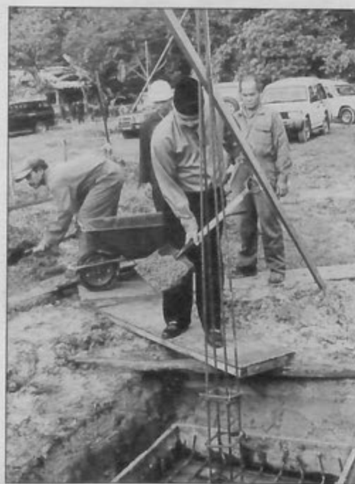
PEGAWAI Daerah Belait, Awang Adnan bin Haji Hanafiah ketika menuang simen bagi mendirikan tiang asas Rumah Panjang Malayan yang baru.
