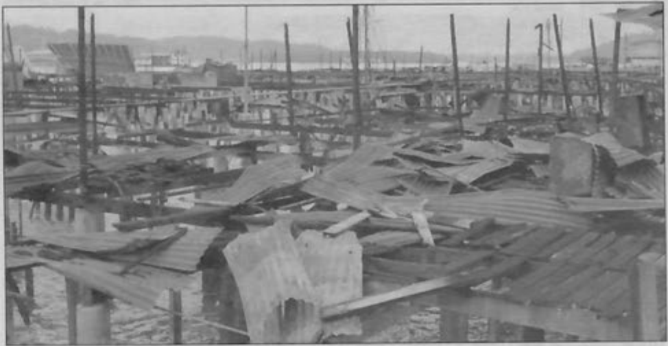
KEBAKARAN yang berlaku di Kampong Ujong Kelinik dan Kampong Lurong Sikuna di Kampong Ayer baru-baru ini.
