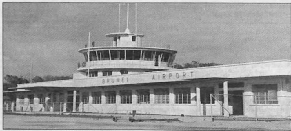
BANGUNAN Terminal Lapangan Terbang Lama ini (gambar atas) dirasmikan pada 8 Mei 1957 bagi menggantikan bangunan terminal kajang. Bangunan ini dilengkapi dengan ruang legar yang luas, ruang untuk minum dan persinggahan penumpang. Bangunan ketika ini digunakan sepenuhnya oleh Jabatan Percetakan Kerajaan.
