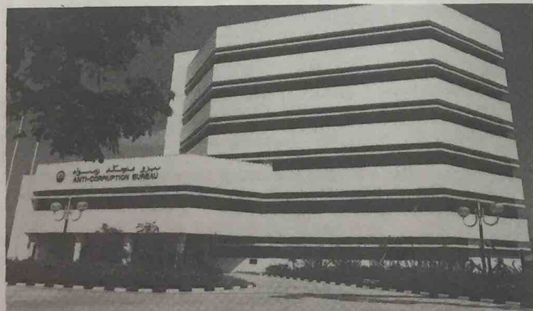
BANGUNAN BIRO MENCEGAH RASUAH tersergam indah yang terletak di bekas Lapangan Terbang Lama, Bera.
