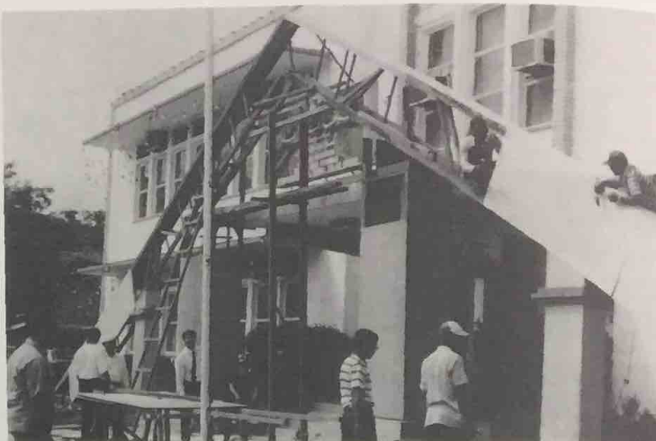
PEKERJA-PEKERJA Jabatan Lembaga Bandaran, Bandar Seri Begawan sedang sibuk memasang pintu gerbang di hadapan bangunan jabatan tersebut.
