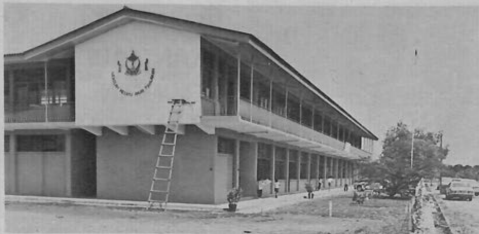
SALAH sa-buah bangunan sekolah rendah Melayu yang berbentuk kekal telah di-bena untuk kemudahan belajar bagi anak2 di-sekitar Kampong Perpindahan Burong Pingai, Berakas.
