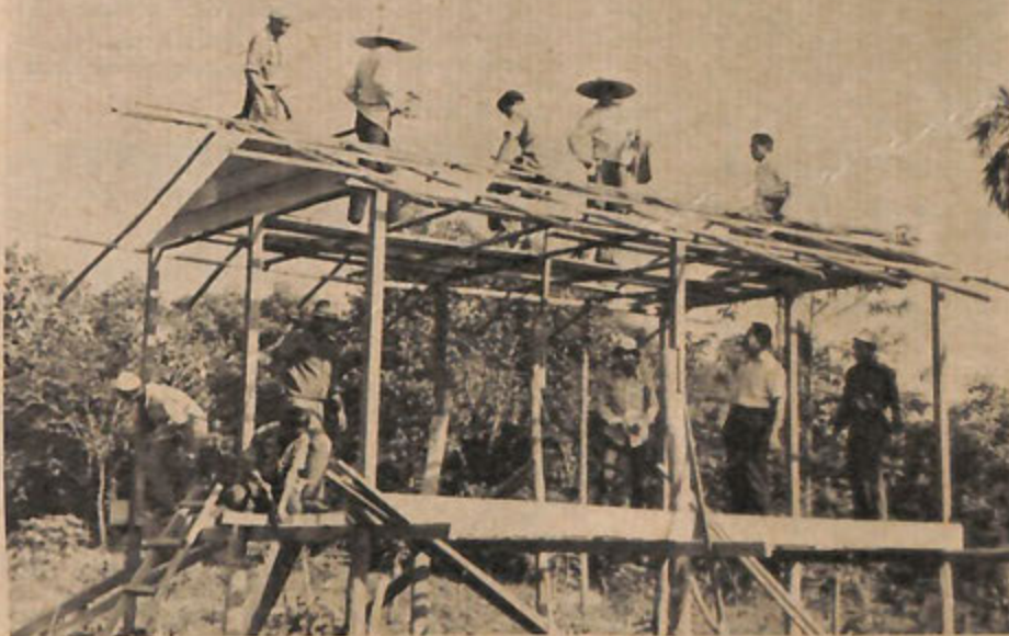
Gambar atas menunjukkan sa-bahagian dari penduduk2 Kampung Kasat sedang bekerja mendirikan rumah untuk Dayang Aminah.
