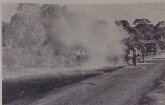
Pekerja2 terpaksa menghadapi hawa yang terlalu panas pada sa-tiap kali aspal di-bubuh. Keadaan itu memang perkara yang biasa bagi menjamin pematatan dan kekukuhan jalan2 raya itu.
