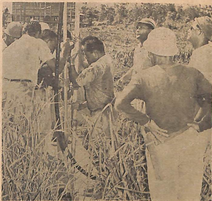
Gambar atas menunjukkan ketika di-jalankan kerja2 menanamkan paip ka-dalam tanah yang menghubungkan alat pengepam itu. Perchubaan ini di-jalankan di-Kampung Terunjing, tetapi tidak berjaya.
