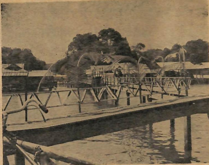
Ini-lah jambatan yang menghubungkan bandar dengan Kampong Limbongan dan Ujong Bukit yang di-bina di-bawah ranchangan luar bandar yang di-usahakan oleh Pejabat Daerah Brunei-Muara.
