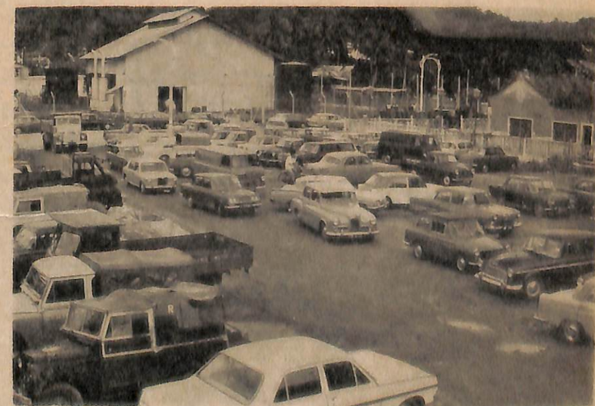
Kenderaan yang di-taruh berselerak ini tanpa sistem penarohan yang teratur menunjukkan kepadatan yang selalu terjadi di-kawasan bangunan lama Jabatan Kenderaan Darat.
