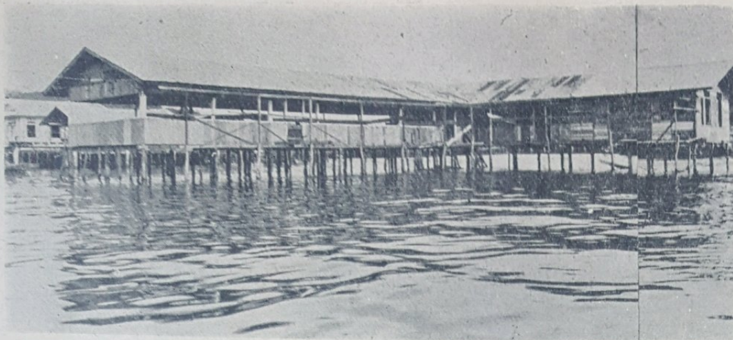
Ini-lah satu pemandangan Rumah PATUH yang hampir siap pembenaan-nya di-Kampung Si-Raja Muda B", Kampong Ayer, Brunei. Pembukaan Rasmi Rumah PATUH itu di-jangka akan di-langsungkan dalam bulan Ogos tahun ini.
