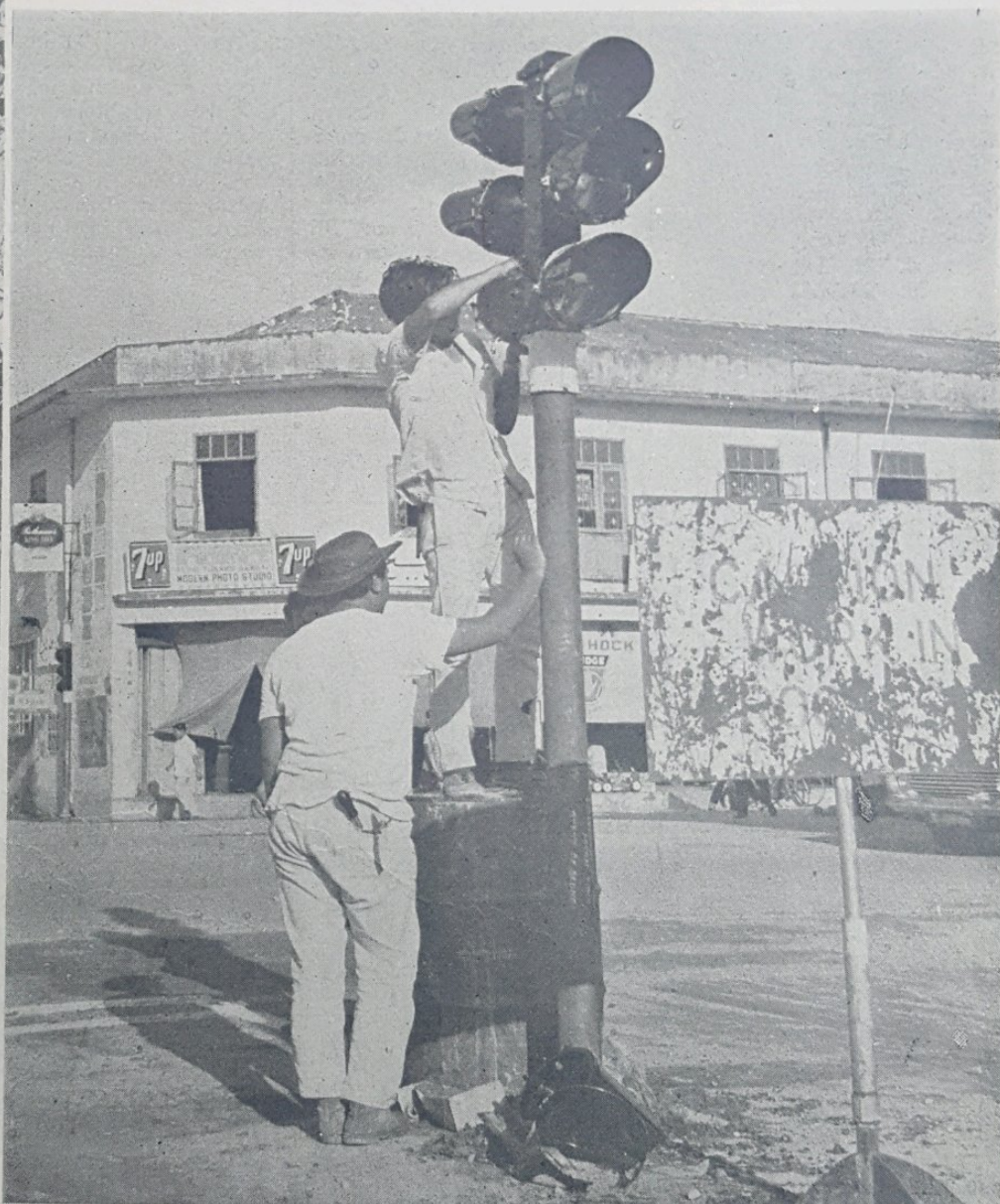
Anggota2 dari Jabatan Elektrik Negeri Brunei kelihatan pada masa mereka sedang memasang sa-buah lampu lalu lintas di-simpang Jalan Sultan dan Jalan Chevalier.
