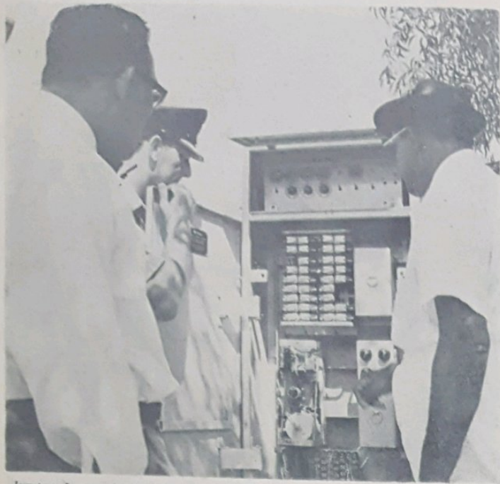
Juruteru Lampu Awam, Negeri Brunei, Awang S. Palaniandy (kanan) kelihatan dalam gambar ini sedang memberi penerangan kepada Ahli2 Jawatan Kuasa Kenderaan, Lembaga Bandaran, Brunei bagaimana cara "Traffic Controller" ia-itu alat yang menyinarakan lampu2 lalu lintas bergerak.
