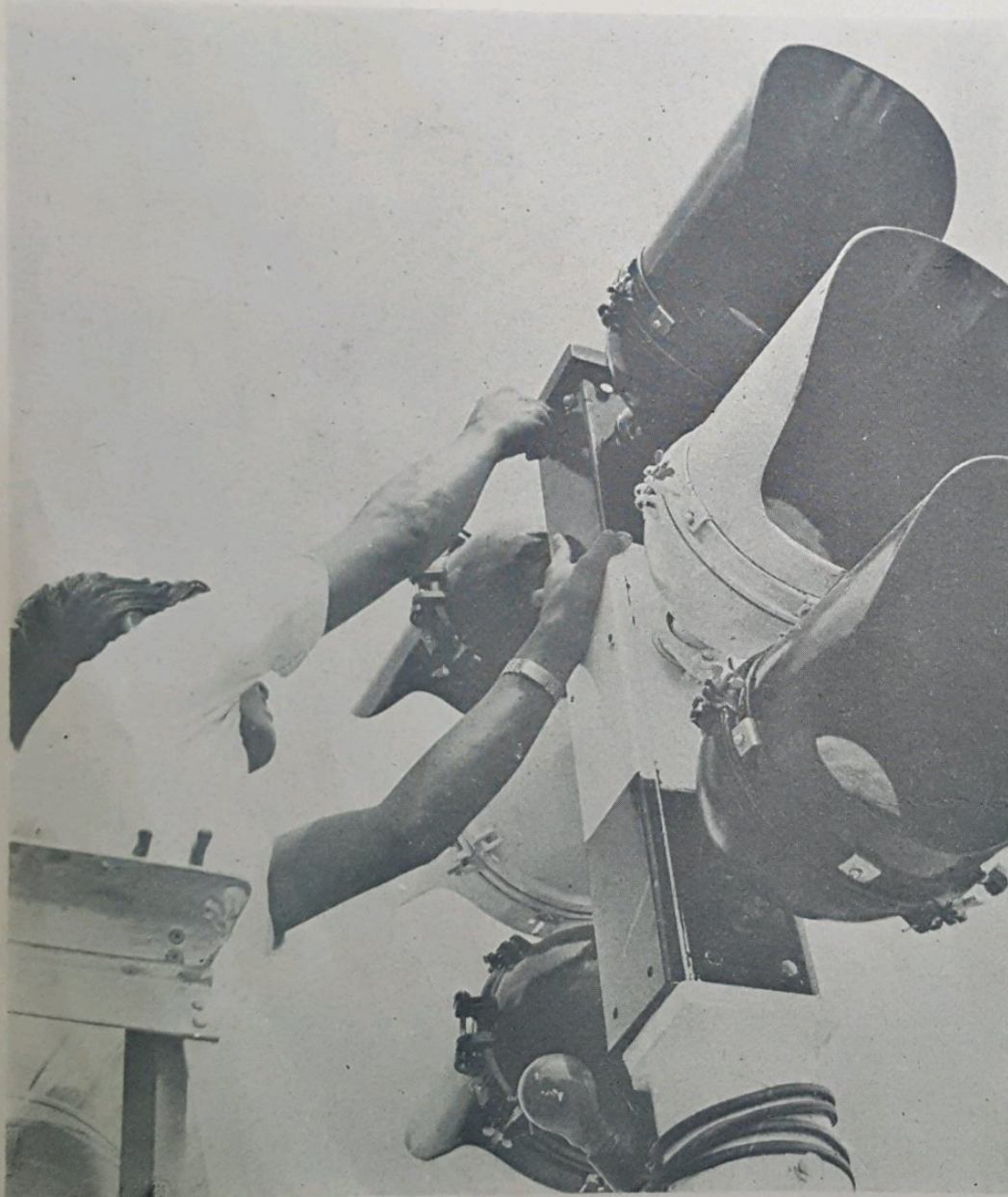
Sa-orang anggota dari Jabatan Elektrik Negeri Brunei sedang memasang "Aspect" di-dalam "Traffic Hood" di-sabuh tiang lampu lalu lintas di-simpang Jalan Sultan dan Jalan Chevalier.
