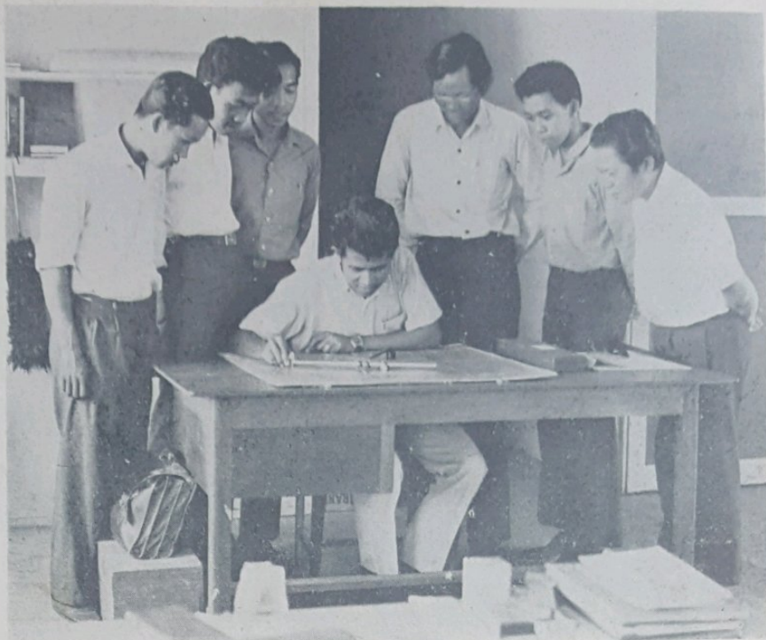
Awang Md. Taib sedang menunjukkan kepada pelatoh2 itu satu cara mengira keluasan dengan menggunakan alat planimeter.
