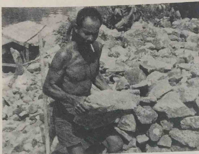
Gambar atas menunjukkan sa-orang pekerja sedang memunggah "batu pasir" untuk penembok jalan raya yang sedang di-bena itu. Menurut pekerja ini, batu tersebut di-datangkan dari Pulau Baru2 yang sengkaja di-datangkan khas untuk mengukuhkan keadaan jalan raya itu yang pada mula-nya berasal dari tanah paya.
