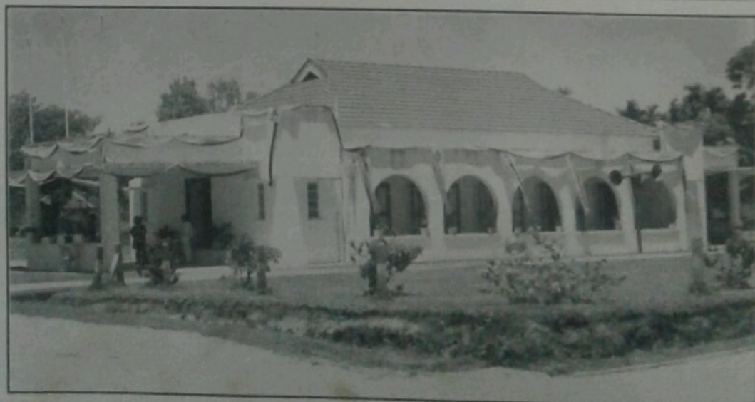
Majlis Meshuarat Negeri Brunei telah mengadakan persidangan-nya di-bangunan Lapau Diraja (di-atas) sa-hingga bulan December lepas. Keputusan telah di-ambil untuk majlis itu bersidang di-dewan Civic Centre pada masa hadapan dan bangunan Lapau Diraja itu di-jadikan Pejabat Pegawai Hal Ahwal Ugama Brunei.
