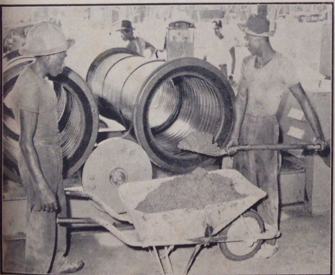
Gambar di-atas menunjukkan pekerja2 kilang paip ayer sedang menyiapkan paip2 yang di-buat di-situ.
