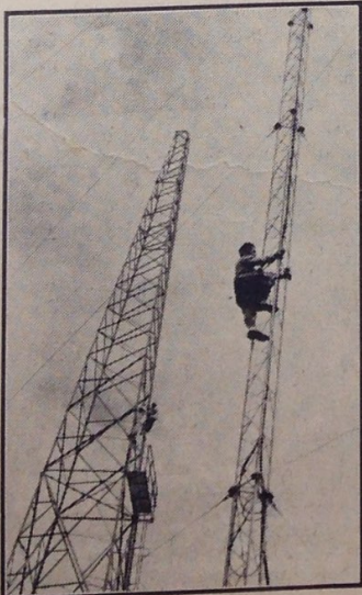
Kiri — Pekerja2 sedang memanjat menara; kanan, satu lagi pemandangan Bandar Kuala Belait dari menara VHF
