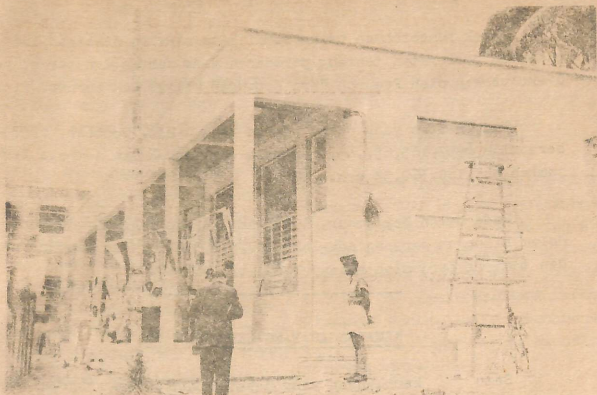
Bangunan Telephone Automatik di Bandar Brunei yang telah dibuka dengan resminya oleh Yang Teramat Mulia Seri Paduka Duli Pengiran Bendahara, Pemangku Al-Sultan, pada hari Sabtu 5 October, 1957.
