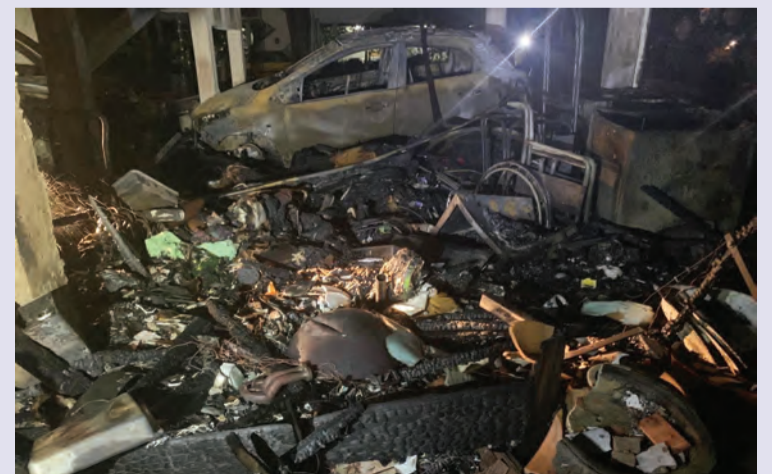
DUA buah kenderaan turut musnah dalam kejadian kebakaran yang berlaku di No. 127, Simpang 125, Jalan 11, Kampung Perpindahan Lambak Kanan pada malam Isnin, 27 April 2020.
