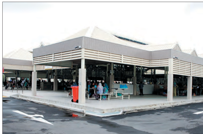
BANGUNAN Pasar Pelbagai Barangan Gadong yang baharu lebih kondusif dengan kemudahan-kemudahan bagi para peniaga dan pelanggan.
