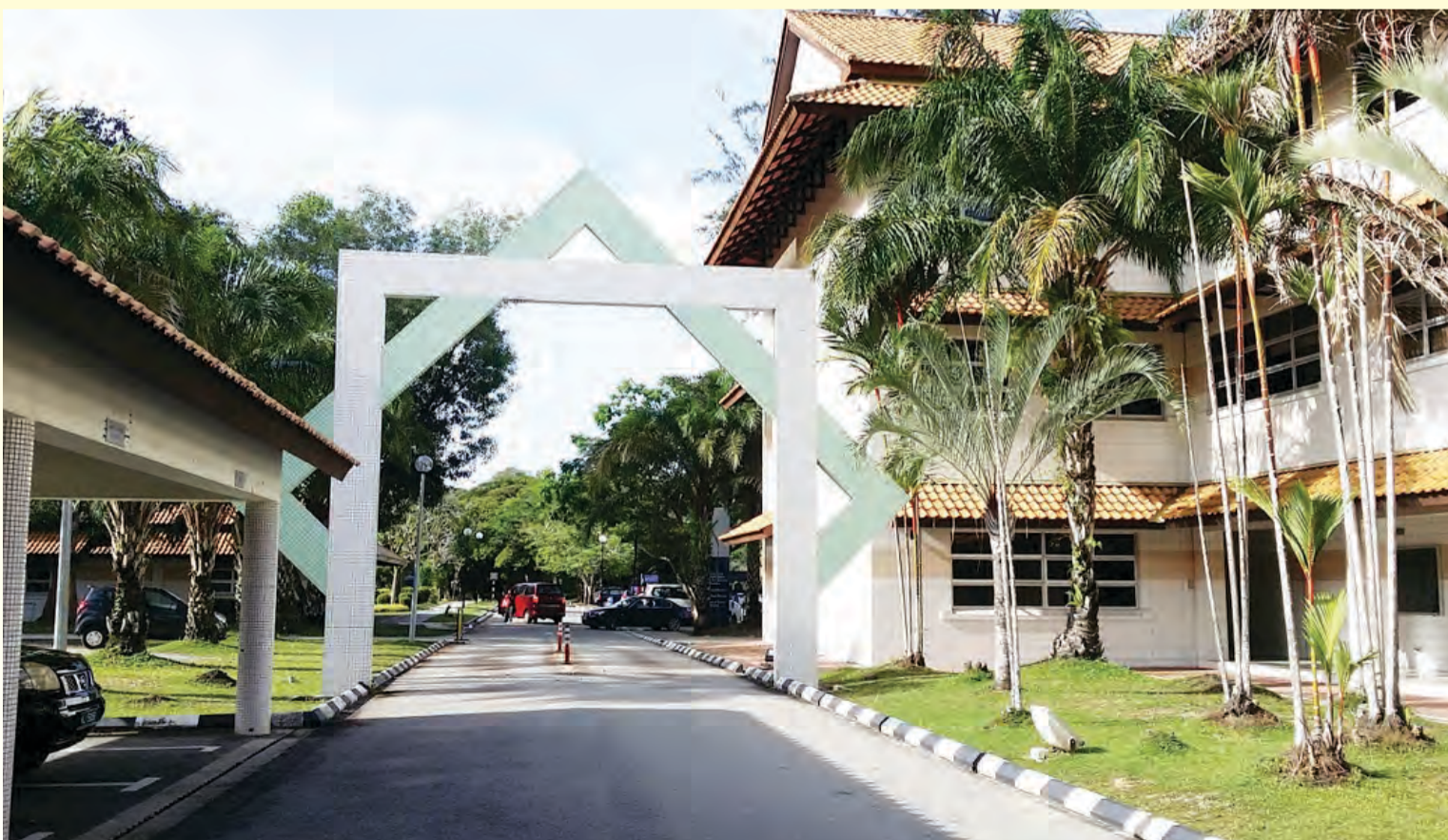
BANGUNAN Akademi Pengajian Brunei
