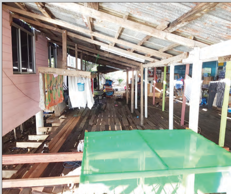
SURAMBI yang sedang diperbaiki akibat kejadian surambi roboh di rumah Kampung Setia 'B' pada malam Sabtu, 25 Mac yang lalu.
