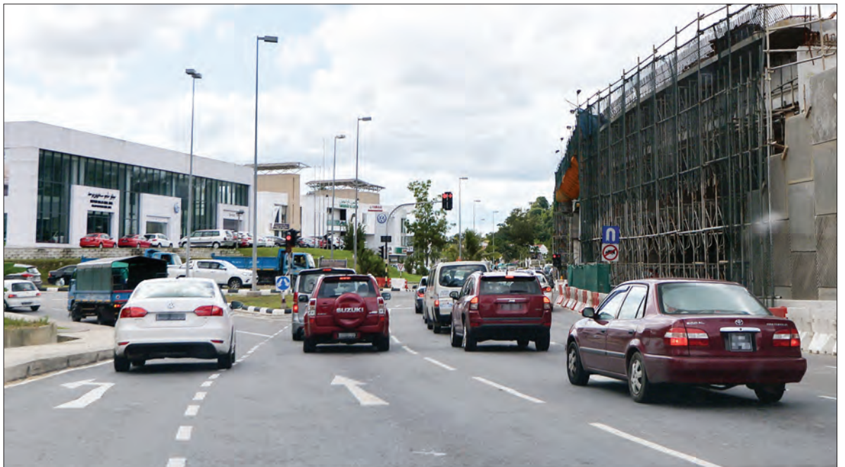
PENGUNA jalan raya diingatkan untuk mematuhi peraturan, di samping peka dengan keadaan sekeliling terutama, di mana terdapat kawasan-kawasan pembinaan.
