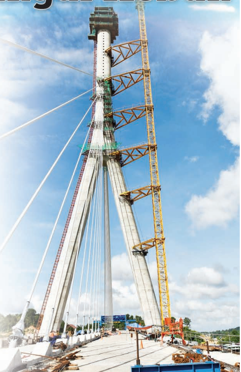
PEMBINAAN projek jambatan yang menyeberangi Sungai Brunei dari Kampung Sungai Kebun ke Jalan Residency kini rancak dalam pembangunan. - Foto : Mohamad Azmi Awang Damit.
