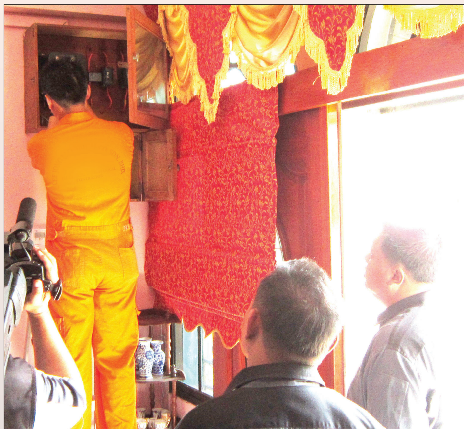
PEMASANGAN Meter Pra Bayar dipantau oleh wakil dari Jabatan Perkhidmatan Elektrik.
