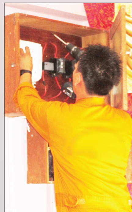
PEMASANGAN Meter Pra bayar yang dikendalikan oleh kontraktor yang dilantik Jabatan Perkhidmatan Elektrik.
