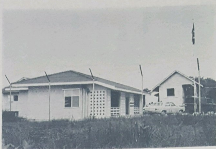
Gambar atas ia-lah bangunan baru Balai Polis di-Sengkurong bagi menggantikan bangunan lama (di-kanan sekali). Bangunan ini di-bena dengan bentok yang moden. Sa-lain dari bangunan ini, di-bena juga sa-direkt bangunan barek yang letak-nya di-belakang bangunan Balai Polis itu.
